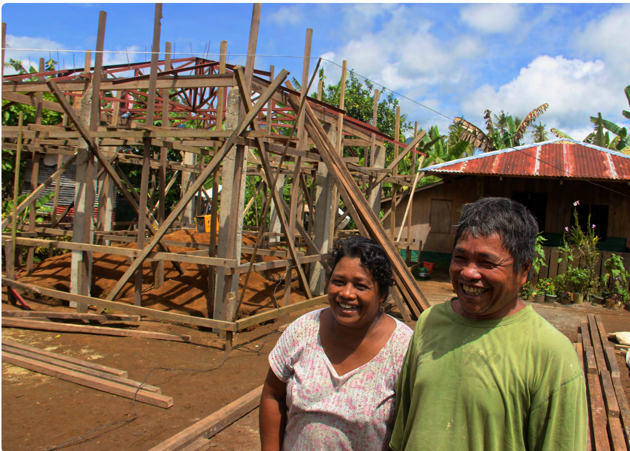
Um casal em Palacio participando da reconstrução de sua própria casa projetada para ser mais resistente a tufões nas Filipinas
