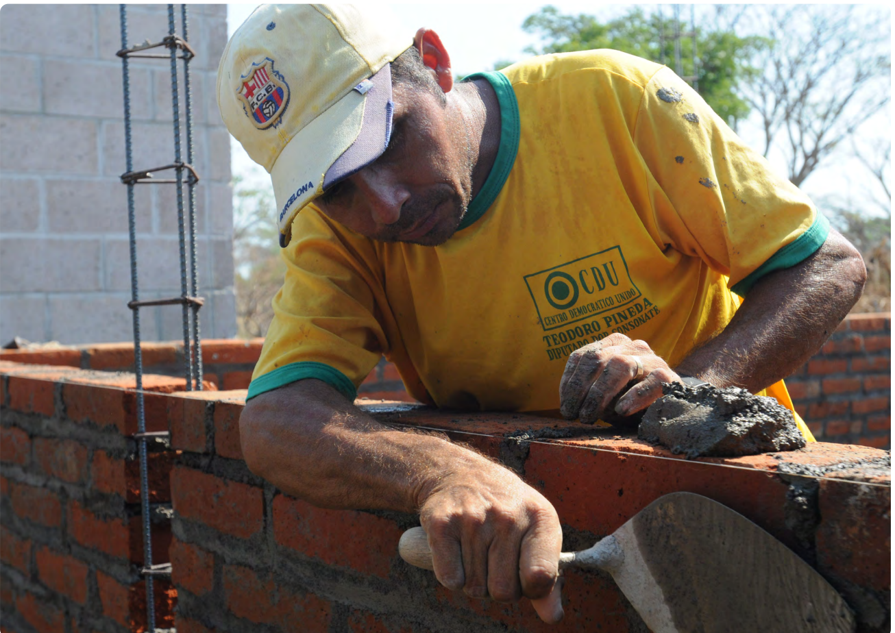
Reconstrução de casas em El Salvador em uma base mais alta para ser resiliente às inundações
